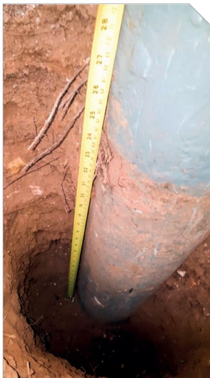
**Figura 4 – Abertura de cavas nos pilares para a verificação da profundidade das sapatas**
